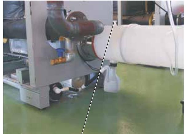
Измерительное отверстие на конденсатоотводчике
