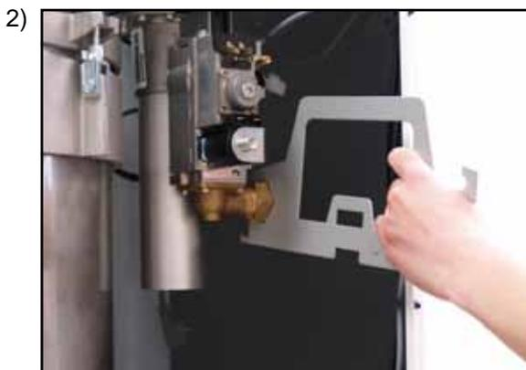
Отсоединить подключение газа к комбинированному газовому клапану
