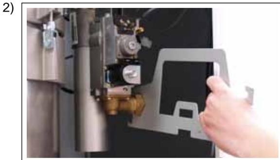
Отсоединить подключение газа к комбинированному газовому клапану
