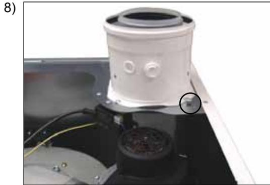
8) После снятия верхней крышки обшивки котла необходимо отвинтить самонарезающие винты фиксатора воздушной/дымовой трубы.
