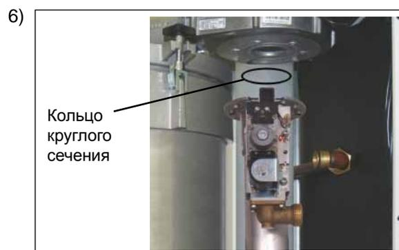
После сборки газовой дроссельной заслонки, газового комбинированного клапана и воздухозаборного патрубка вложить смазанное силиконовое смазочное кольцо круглого сечения в соответствующий паз вентилятора и смонтировать смешивательную камеру.
