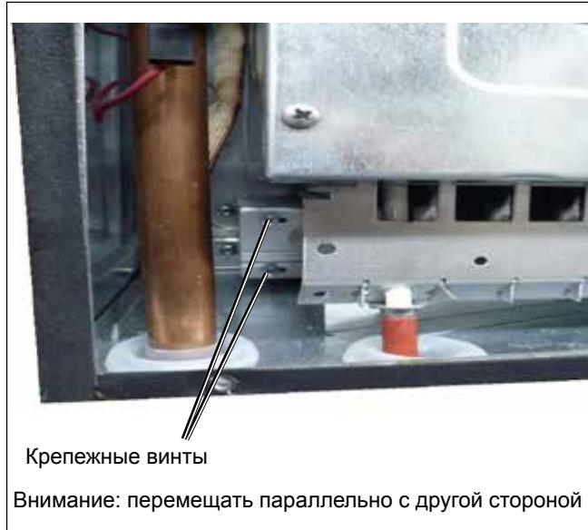
Рис. Корпус камеры сгорания
