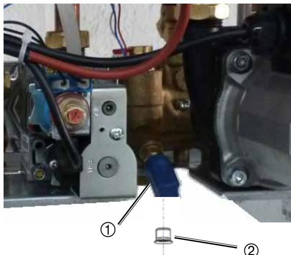
Рис. Сетчатый фильтр для холодной воды
