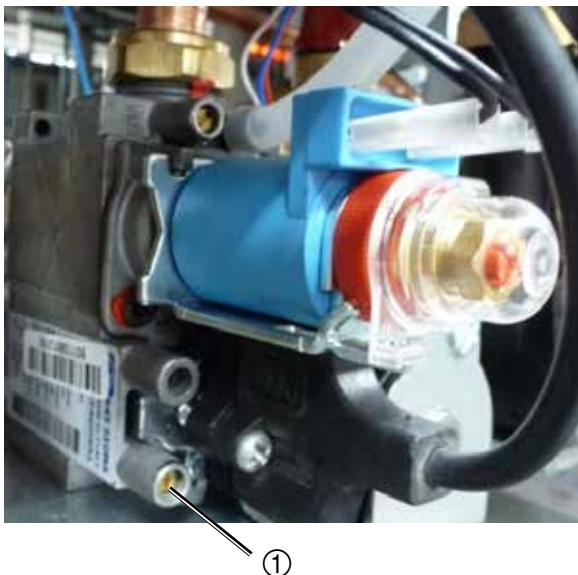
Рис. Комбинированный газовый клапан
